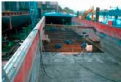
GMS MURGTAL: 34 m neuer Innen- und Außenboden, Einbau Intercostalbleche
