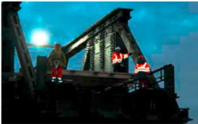
Bis weit in die Dämmerung wurde in luftiger Höhe gearbeitet
